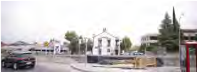
Plaza de Madrid desde donde partirá la pasarela
